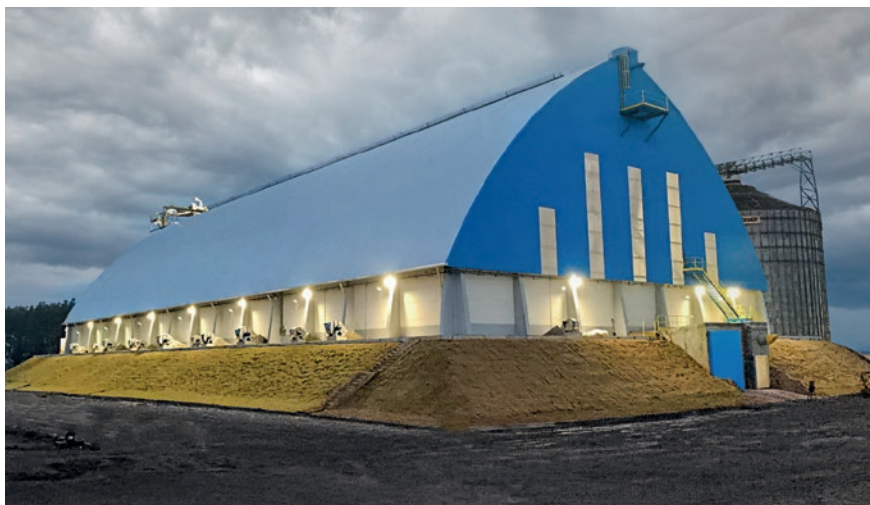
Novo armazém da unidade de Terra Roxa 2: capacidade ampliada
