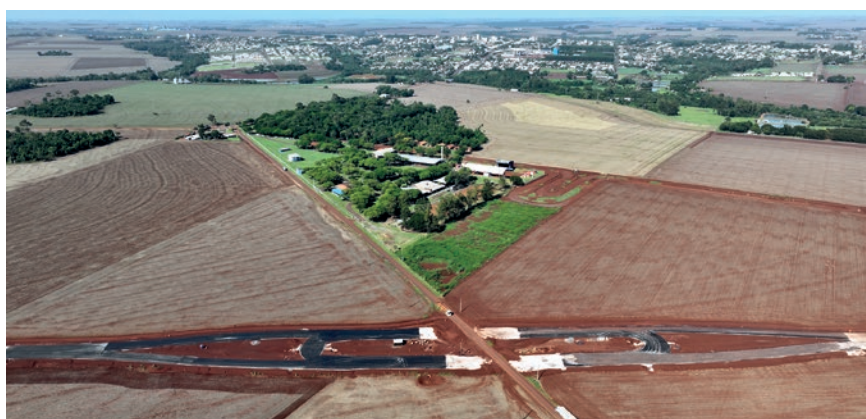
Operários trabalham em trecho de rodovia que faz parte do contorno viário de Palotina
