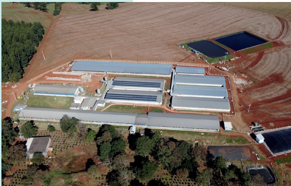
Granja Toca da Onça: 10 barracões e autossuficiência em energia com biogás e luz solar
