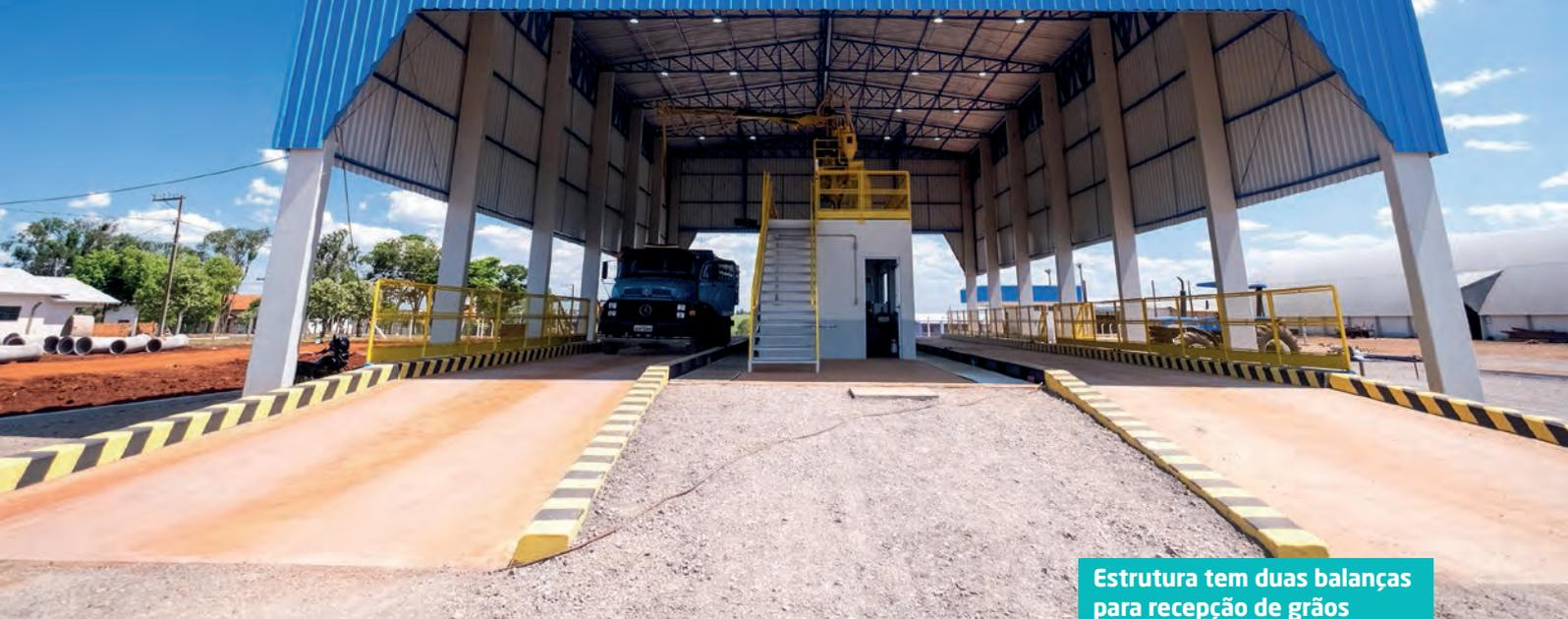
Estrutura tem duas balanças para recepção de grãos
