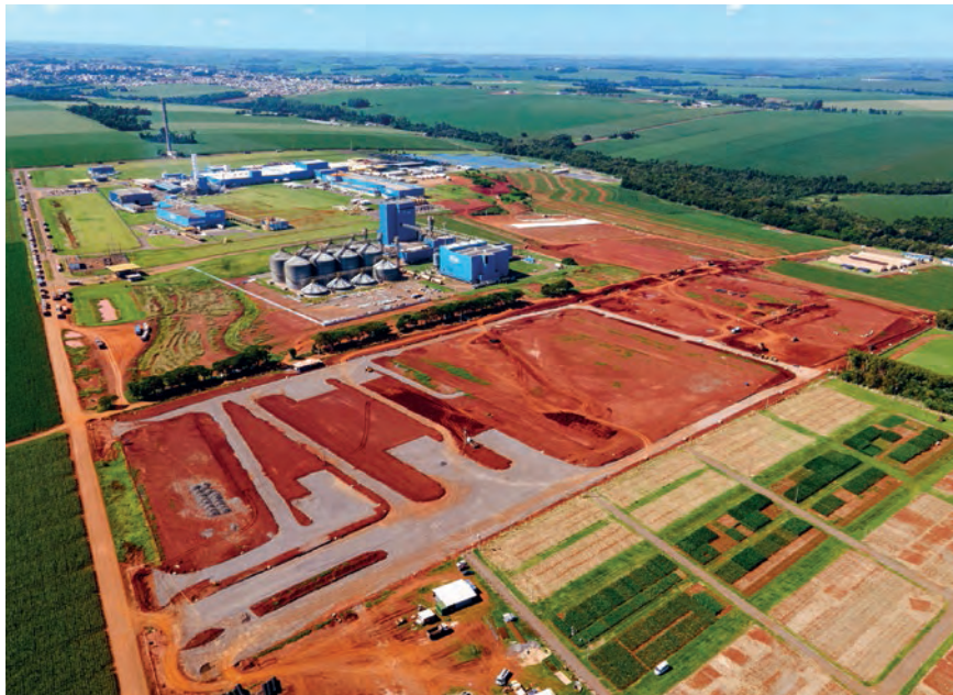
Obras avançam com a realização do sistema de drenagem e da pavimentação
