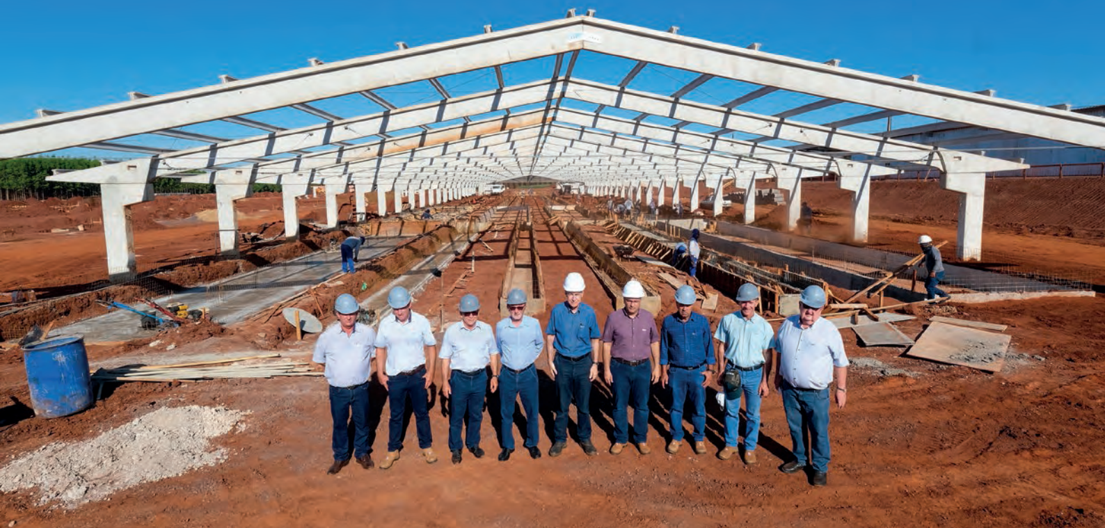
Diretores executivos e conselheiros de Administração da C.Vale conferiram andamento das obras no dia 8 de março
