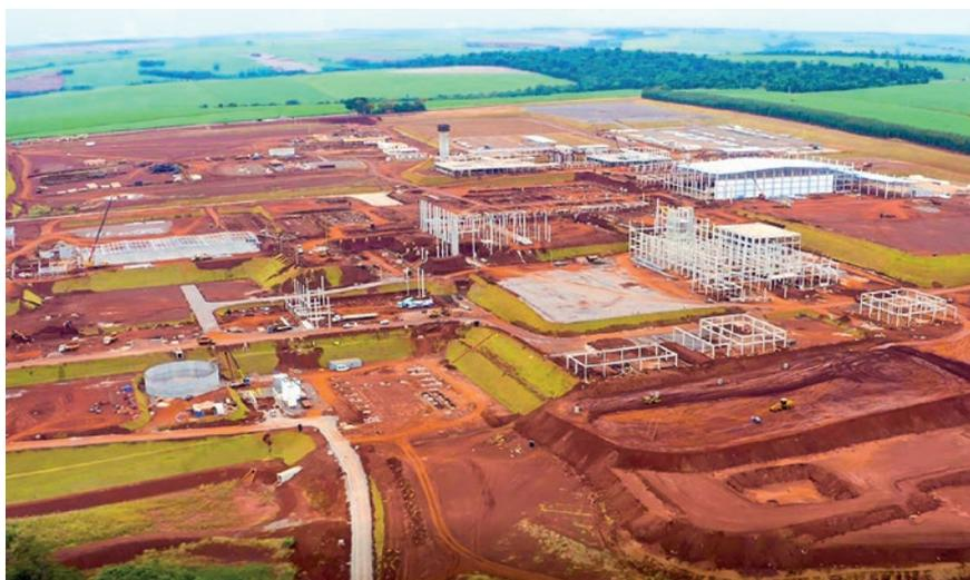
**Obras do frigorífico** avançam com a colocação da estrutura em pré-moldados
