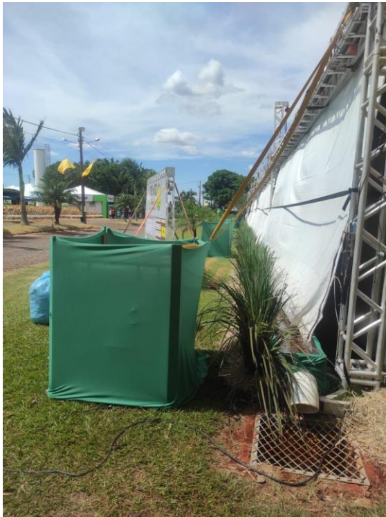
Estrutura não fixada no terreno
