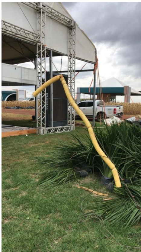
Cabo de aço com envelopamento inadequado
